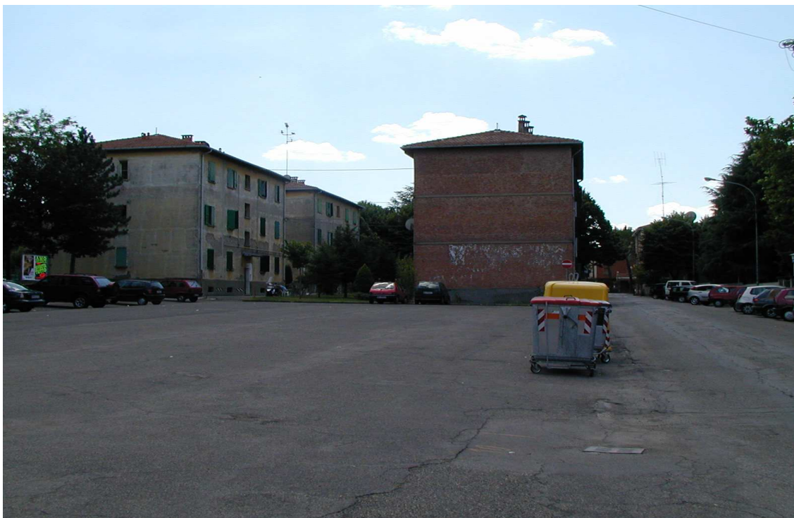
Area prima dell'intervento
